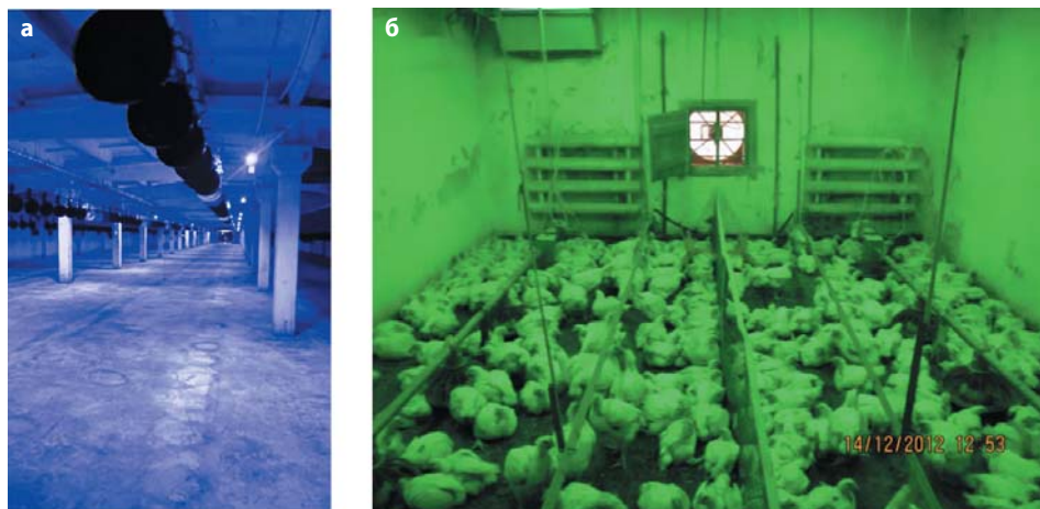
Рис. 8. Светильники с синими светодиодами в птичнике для выращивания цыплят-бройлеров группы «Черкизово» (а) и с зелеными светодиодами в экспериментальном хозяйстве ФНЦ «ВНИТИП» РАН (б)
